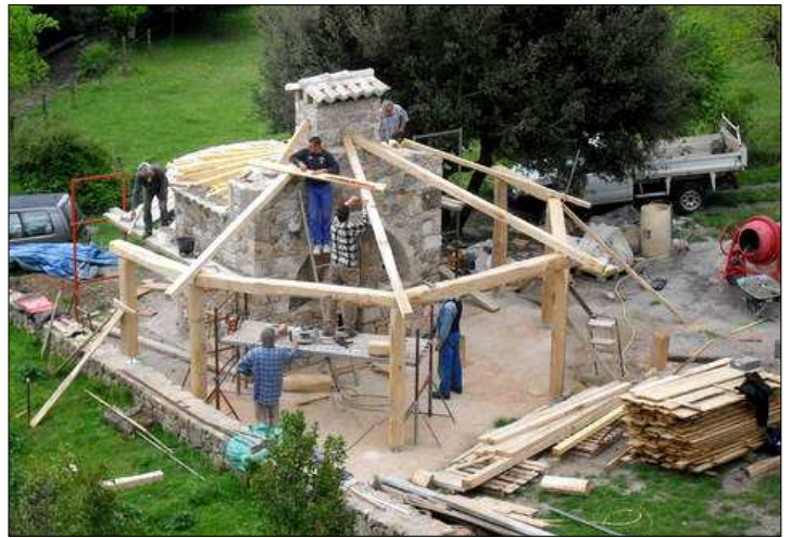
Chantier participatif four banal
